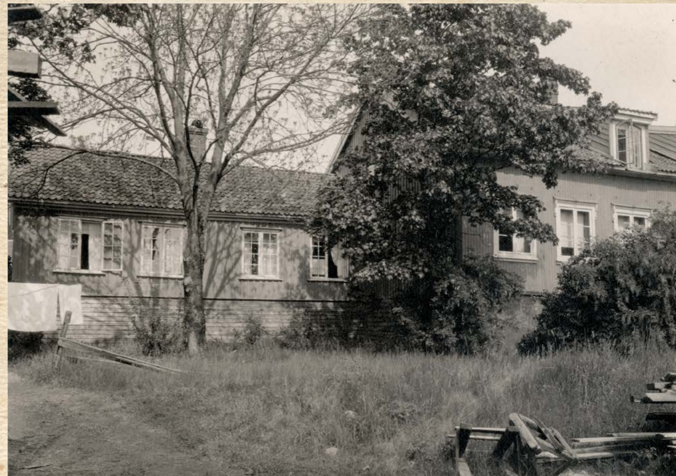
Over: Oberinspektørens bolig, fasaden mot sjøen. Mange har ment at denne bygningen rommer restene etter Langenes Fritsøhus fra før 1650. Legg merke til den panelte grunnmuren. Panelte grunnmurer var ikke uvanlig, og kan i større grad fremdeles sees i Skien. Hovedfløyen til høyre ble forlenget rundt 1900.
