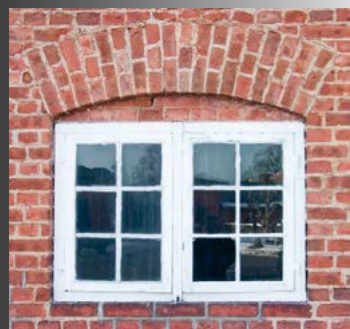
Opprinnelig vindu fra underetasjen. Småruter var fremdeles i bruk i 1850-årene.
