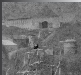
Til høyre i bildet stikker øvre del av marsovn fra 1845 opp med tårn- hatt og bro. Ovenfor er trekullageret. Utsnitt av foto 1865
