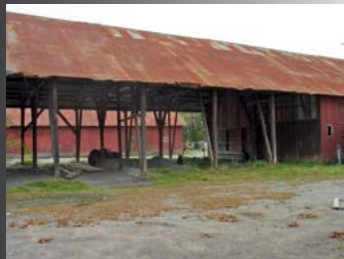
Noen av lagerfløyene er åpne konstruksjoner
