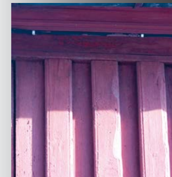
Klokkeboden har mye gammel panel og profilererte detaljer i behold
