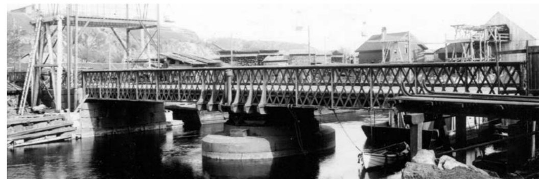
Broen over Farriselven ble bygget med en svingmekanisme
