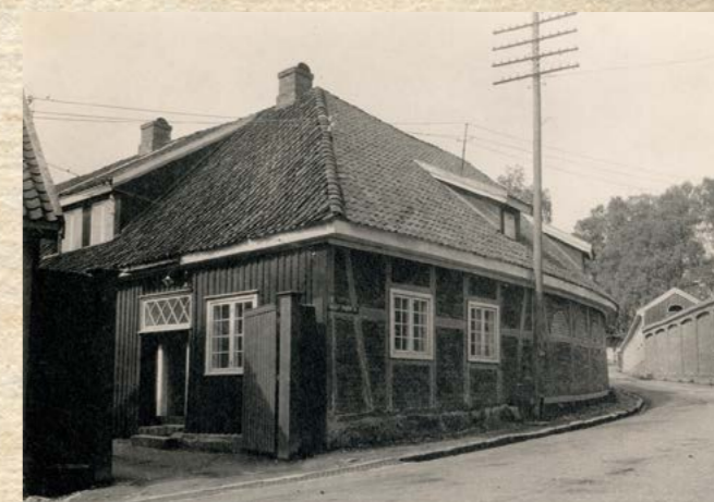
Over: Oberinspektørens bolig, fasaden mot sjøen. Mange har ment at denne bygningen rommer restene etter Langenes Fritsøhus fra før 1650. Legg merke til den panelte grunnmuren. Panelte grunnmurer var ikke uvanlig, og kan i større grad fremdeles sees i Skien. Hovedfløyen til høyre ble forlenget rundt 1900.
