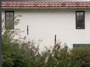
Murankerne viser den eldre og den nyere delen av bygningen
