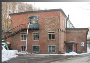
Sydgavlen har en nyere tilbygning
