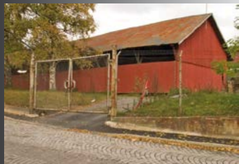
Lagerbygningen på Øvre Værksgård er tilsvarende det gamle tremateriallageret
