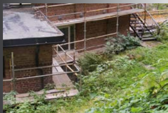
Valseverket er lagt inn i restene av marsovnens forstøtningsmurer
