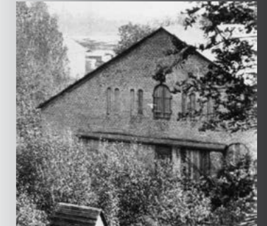
Utsnitt av fotografi fra 1880-årene viser valseverkets gavl med opprinnelig saltak
